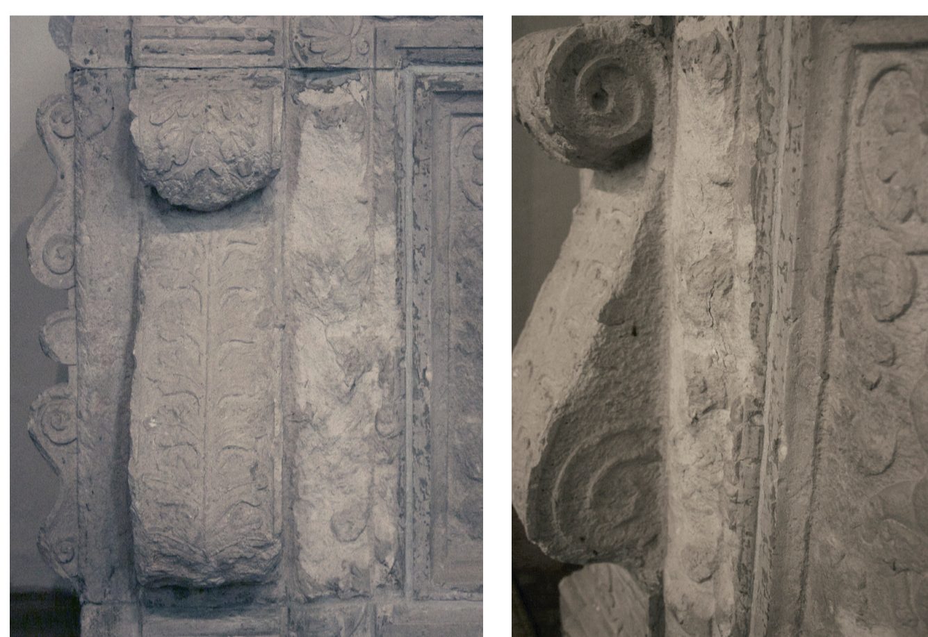
particolare fascia laterale pre intervento
